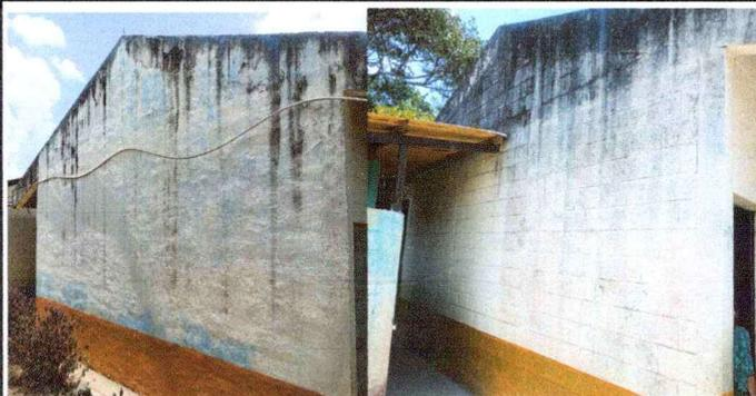
Foto 5: Se observa la presencia de humedad y deterioro de repello y pintura en el módulo en el módulo 1 y 2.
