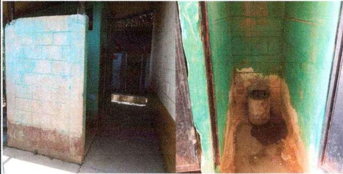
Foto 3: Se observa el deterioro de 6 letrinas con que cuenta la escuela, fosas llenas y colapsadas.
