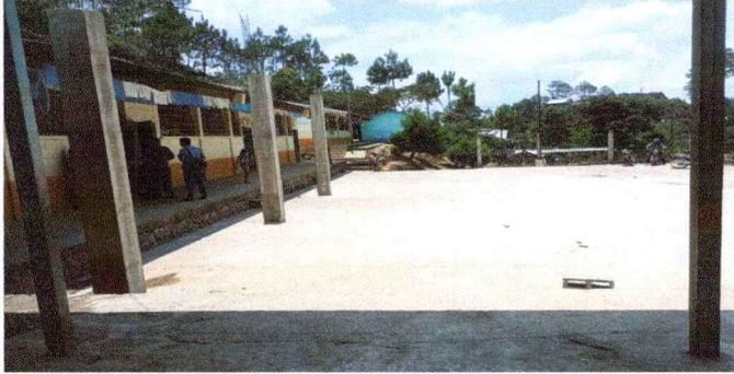
Foto 1: Se desmanteló techo y las bases por deterioro, se inició a levantar columnas para entechar de nuevo con fondos de gratuidad. Medida 21 m x 15 metros.
