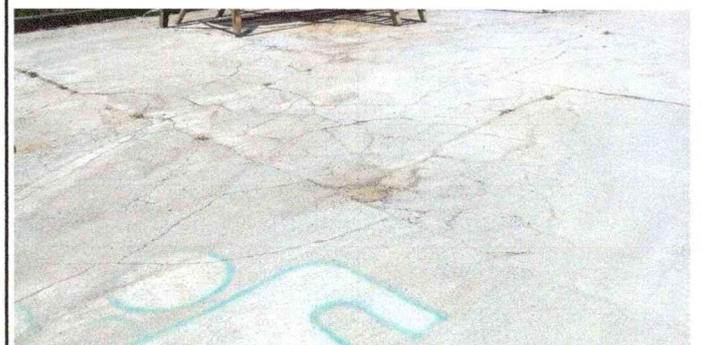
Foto 4: Se observa el deterioro del piso de concreto en el área donde se comenzó el entechado, el total dañado es de 168 m2
